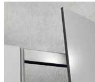
**Collegamento superiore:** un profilo estruso in alluminio anodizzato consente di posizionare i pannelli senza evidenziare i dispositivi di fissaggio. Eccezionale robustezza con funzione antivandalismo.
