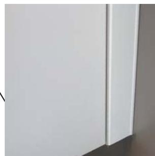
**Giunzione:** realizzata mediante profilo in alluminio anodizzato ad "U" che svolge la funzione di assorbire le tolleranze inevitabili in fase di posa in opera.
