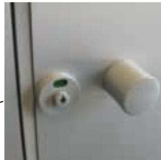
**Serratura lato esterno:** l'indicatore di libero/occupato è dotato di dispositivo che consente l'apertura del battente dall'esterno in caso di emergenza.
