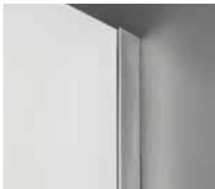
**Angolo a muro:** realizzato mediante un apposito profilo in alluminio anodizzato presenta all'esterno un corretto risvolto lineare ed all'interno le stesse caratteristiche del profilo di collegamento.
