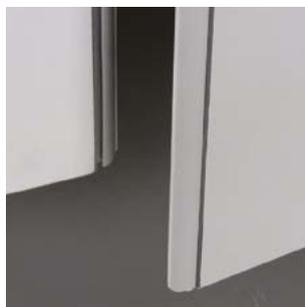
**Battuta porte lato serratura:** realizzata mediante un profilo coestruso in PVC rigido e morbido tale da ottenere un effetto ammortizzatore/antirumore in fase di chiusura del battente.
